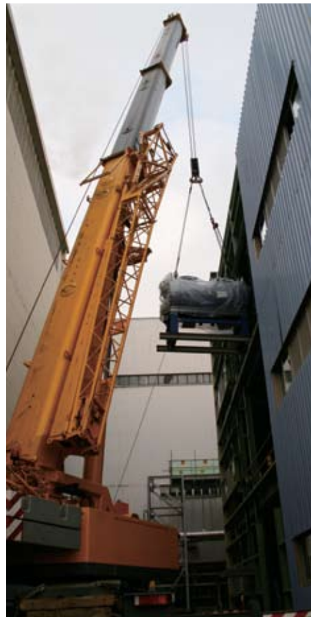
현장 설치 모습
