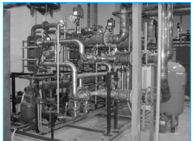
기계실 이지히트 콤비 설치 모습
