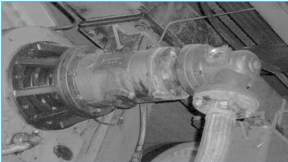
그림 5. 건조실린더 사이폰 관 및 사이트 글라스 설치 모습
