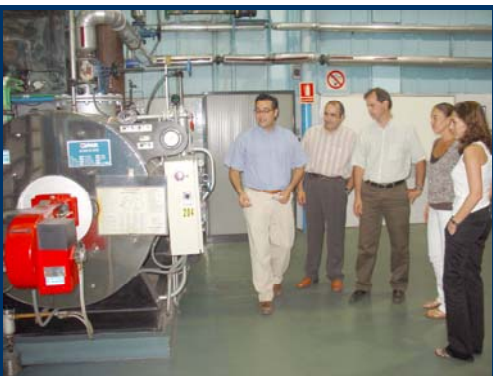
Demostración en sala de calderas
