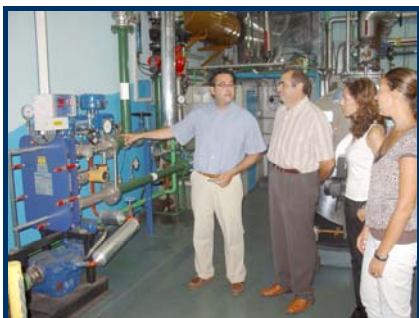
Sistema de intercambio de calor
