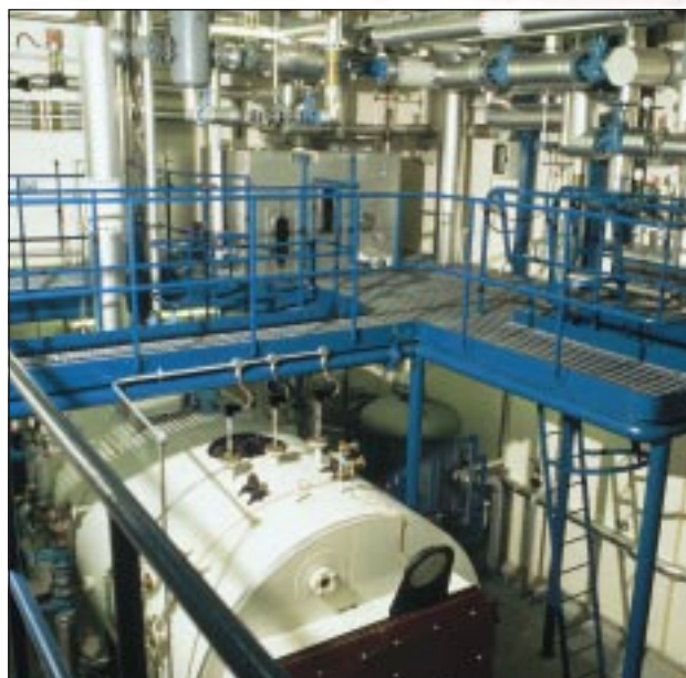
感应探头直接安装在锅壳上
